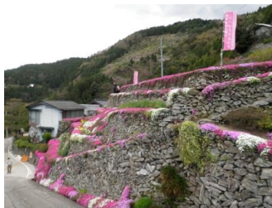
徳島県吉野川市の高開石積み シバザクラまつり 土の流亡を抑えるため、石垣を シバザクラで縁取りした例。
