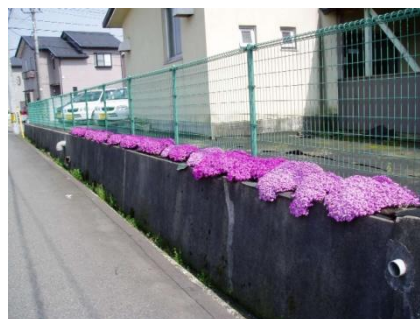
土嚢を用いて工場フェンス下を緑化した事例 コンクリート壁面の上でも、十分に生長する。現在設置8年が経過。
